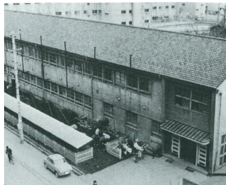
昭和25年(1950)、学校の資金に圭陵会の寄付金を加えて新築した圭陵会病棟(西病棟)。建物疎開で取壊した共同会館の古材も使われている
