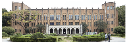
東京大学2号館。昭和2年(1927)、内田祥三設計により医学部本館として建てられた歴史的建造物
